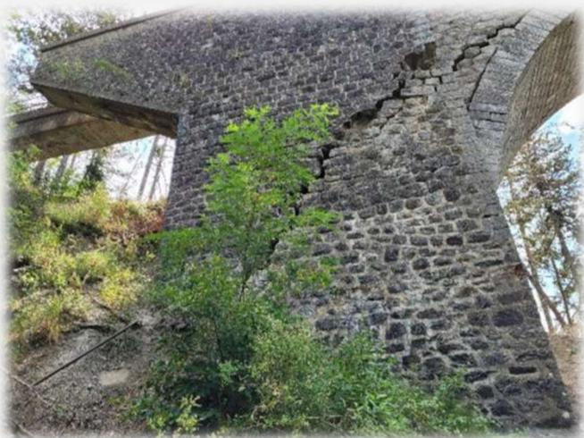
Fracture décimétrique d'une pile-culée
